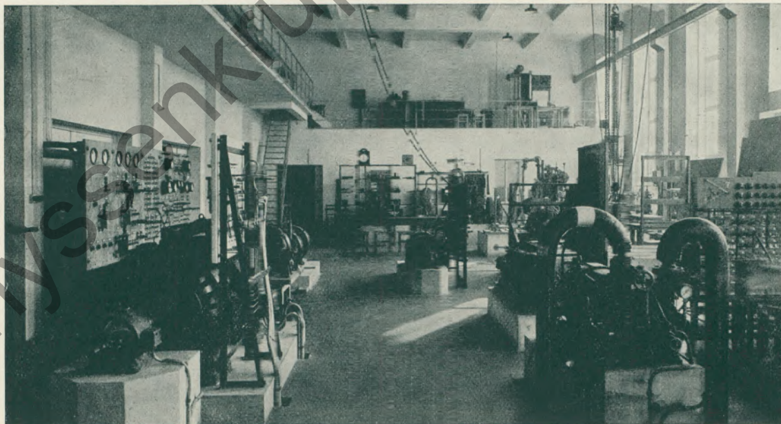
Abb. 5. Institut für Maschinenkunde und Elektrotechnik. Maschinenhalle.
