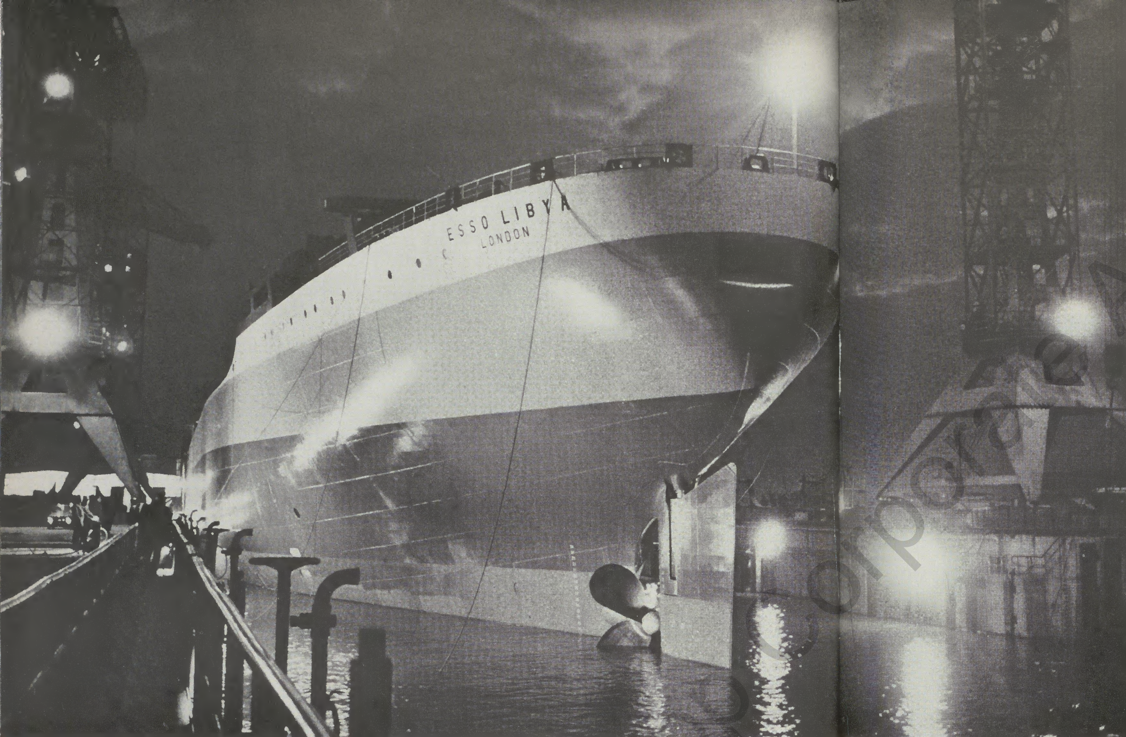
▲ Ausdocken: Das Schleppermanöver von der Schiffsbrücke aus durch Sprechfunk dirigiert
