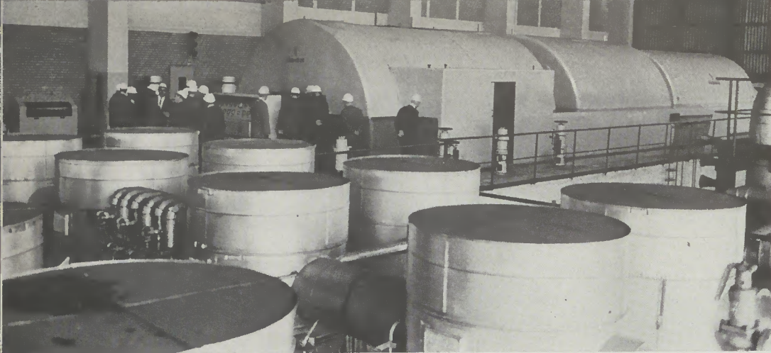
Noch mehr Energien für das Ruhrgebiet: In der Turbinenhalle des Rheinstahl-Großkraftwerkes Marl
