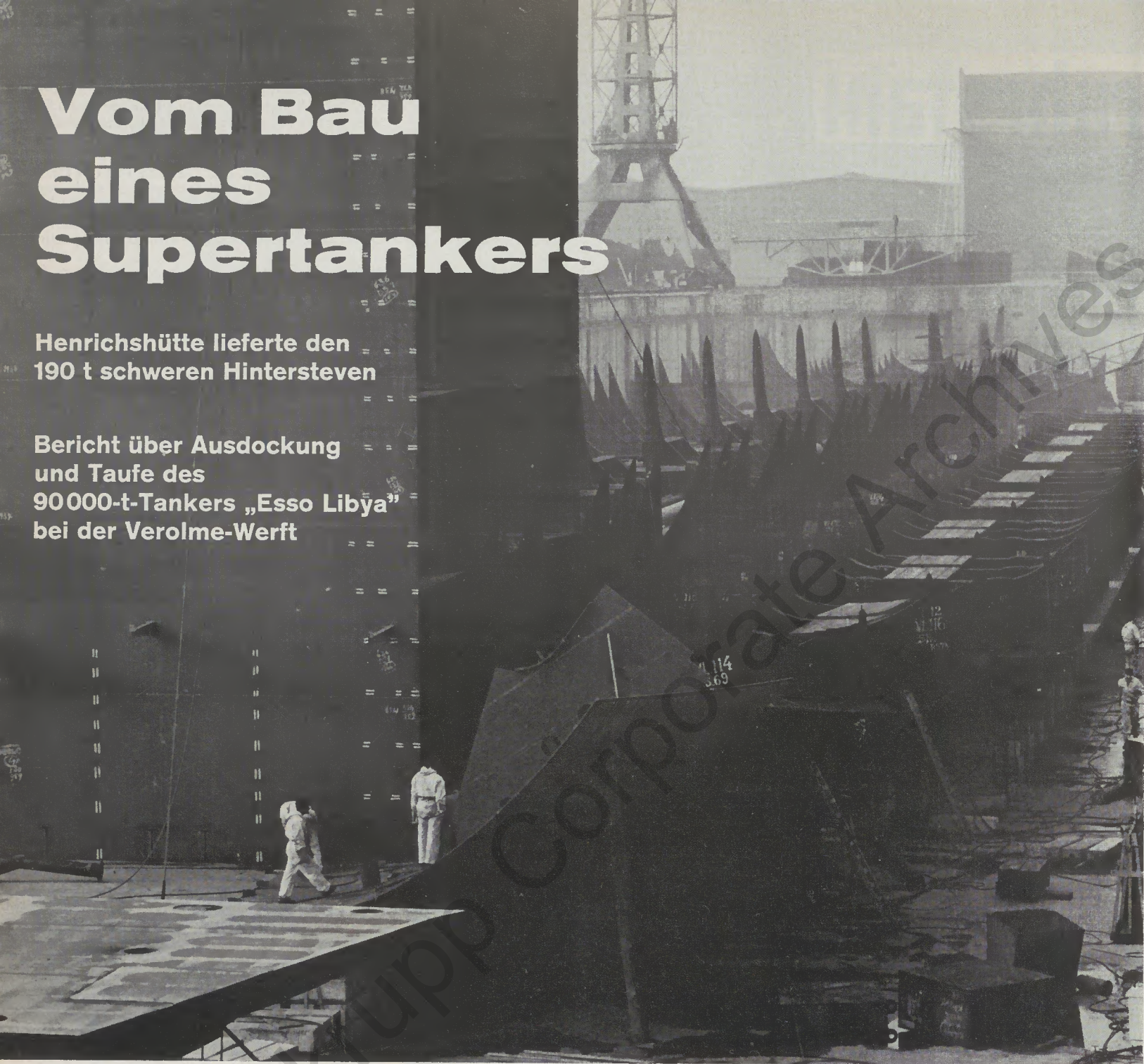
„Esso Libya“ vier Wochen nach Kiellegung: Spanten und Querschotts
