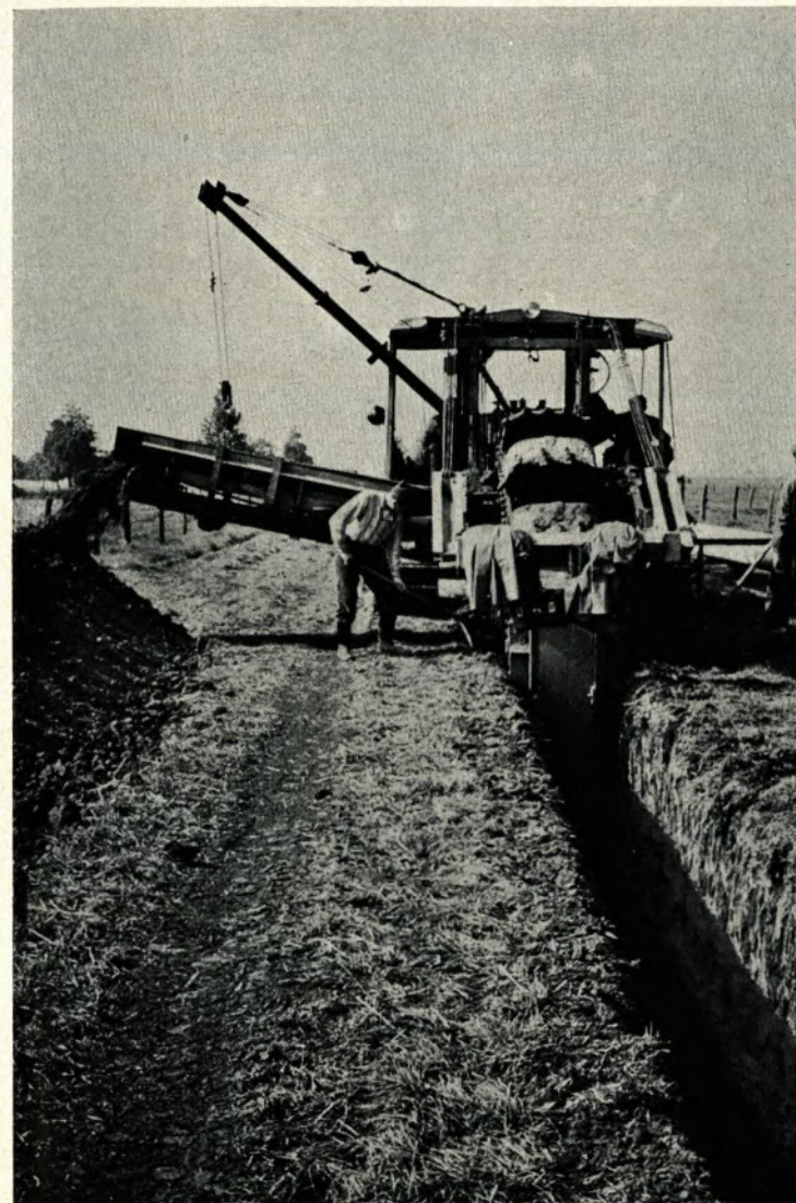
Mit dieser Grabenfräse wurde der Boden ausgehoben und an der Seite aufgeworfen. Nach dem Verlegen der Leitung konnte der Graben dann schnell wieder verfüllt werden. Dieses moderne Großgerät ermöglicht sehr hohe Arbeitsleistungen
