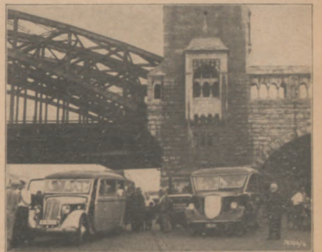
An der Hohenzollernbrücke in Köln
