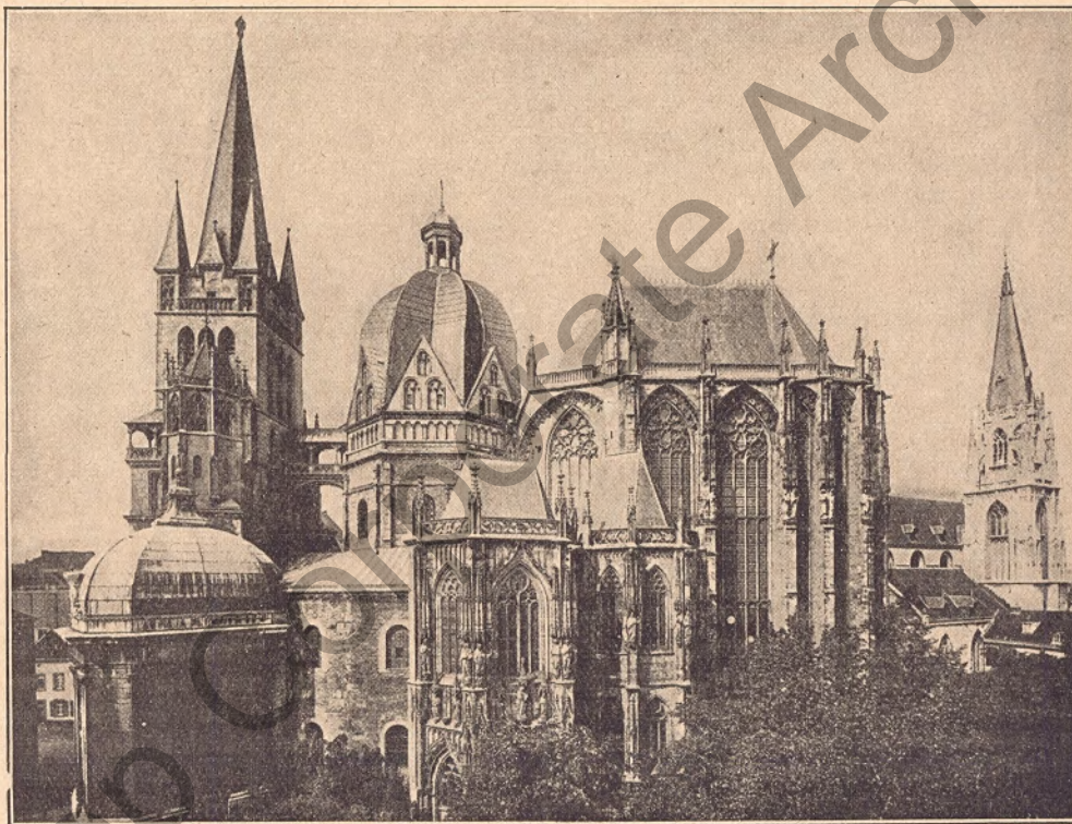
Abb. 10. Münster in Aachen. (Zum Aufsatz auf Seite 178 bis 184.) Unter Karl dem Großen ist nur der in der Mitte befindliche Rundbau — das Oktogon — errichtet; die übrigen Bauten stammen aus dem Anfang des 15. Jahrhunderts. Das Dach des Oktogons ist im 18. Jahrhundert aufgesetzt
