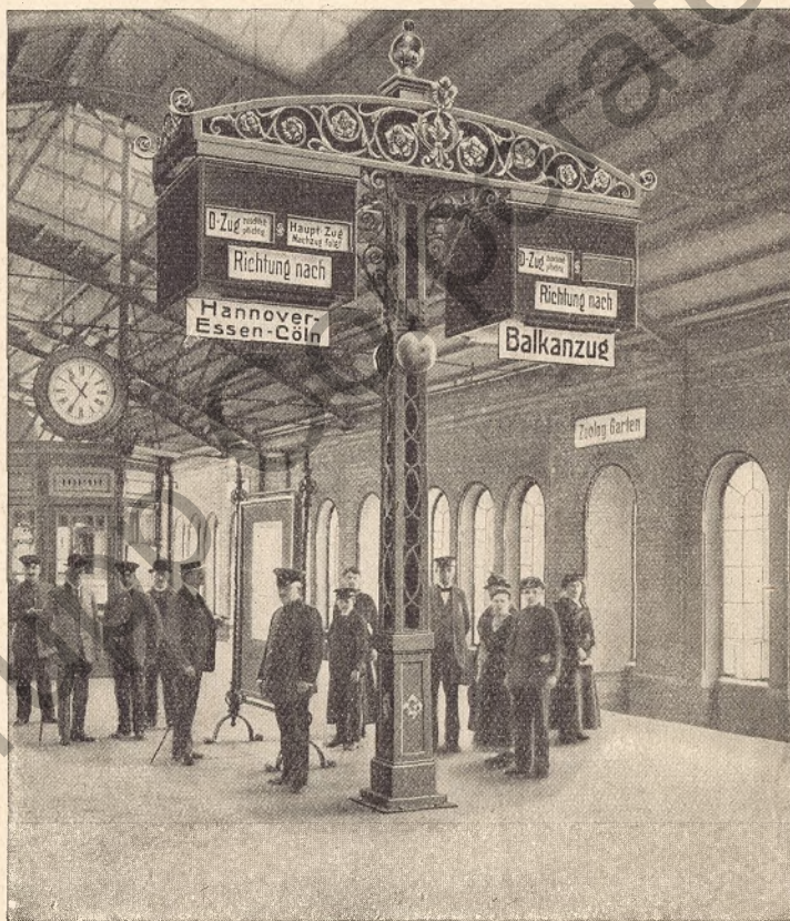
Abb. 8. Elektrischer Zugmelder auf dem neuen Stadtbahnhof Zool. Garten in Berlin. (Zum Aufsatz auf Seite 169 bis 171)
