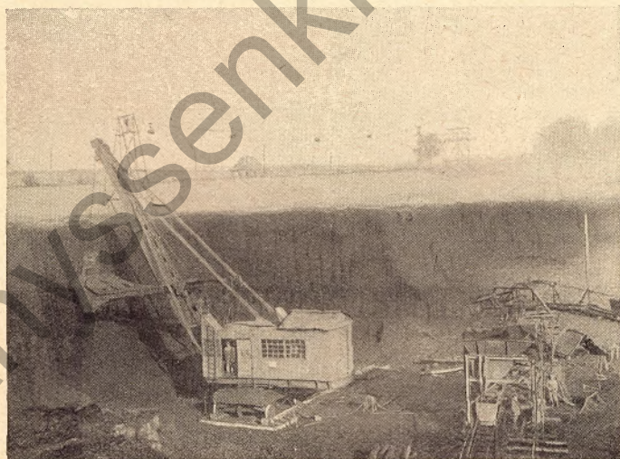
Abb. 8. Löffelbagger, Bauart Carlshütte
