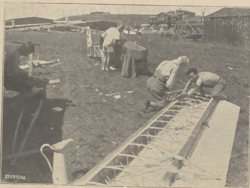
Bei Reparatur-Arbeiten im Fliegerlager auf der Wasserkuppe
