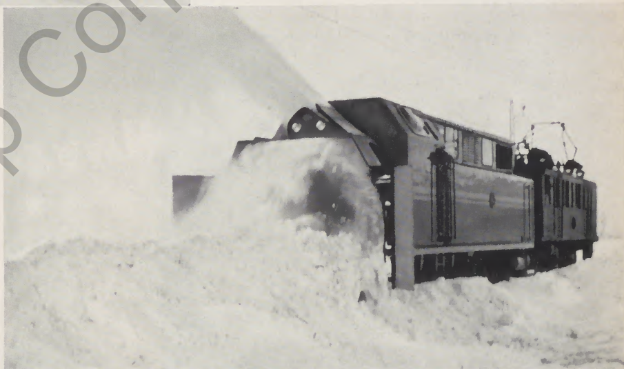
Abb. 1 Rechte Seiten-Ansicht mit Blick auf das Schleuderrad im Bahnhof Kiruna
