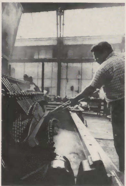
Rückseite: Die meisten Ergebnisse aus Forschung und Entwicklung wirken sich auch auf die praktische Arbeit in den Betrieben aus. Hier ein Blick in das Federwerk der Hohenlimburger Walzwerke: Felix Sczezawinski legt in eine Biege- und Härtemaschine das Hauptfederblatt ein
