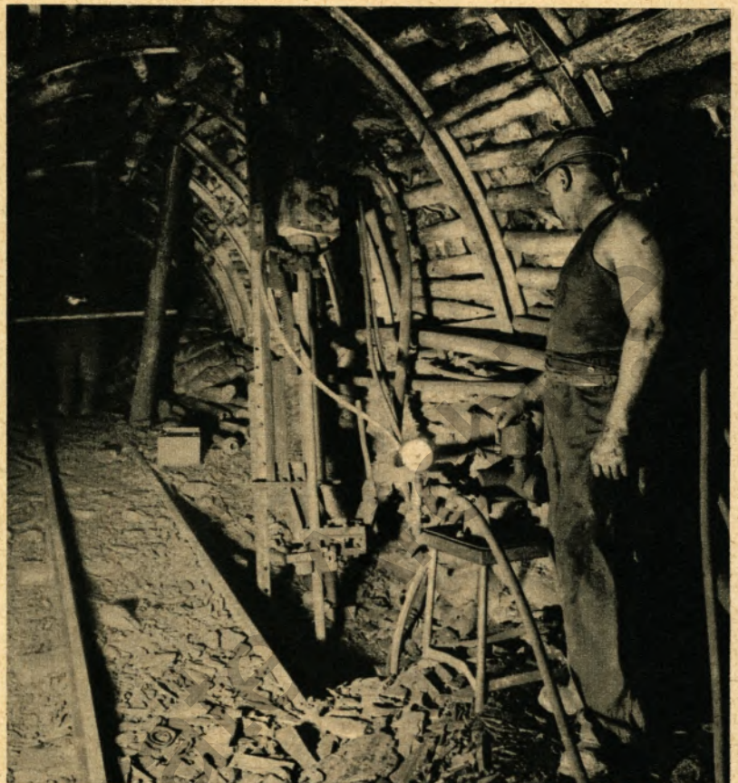
▲ Schlosser Friedrich Hörster überwacht die Bohrmaschine, die ein Loch in das Liegende bohrt, aus dem später Grubengas abgesaugt werden soll
