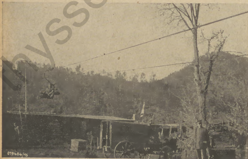
Drahtseilbahn über einen 1000 Meter hohen Gebirgszug in den Ostkarpaten
