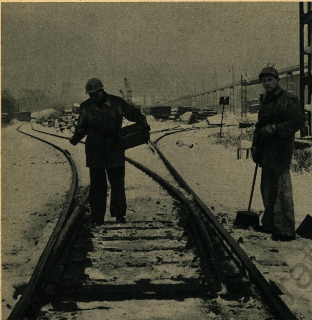
◀ Bei Kälte und Schnee drohen die Weichen unserer Werksbahn auf der Westfalahütte einzufrieren. Helmut Auge streut deshalb Viehsalz, nachdem Manfred Skappeck die Schienen vom Schnee gesäubert hat
