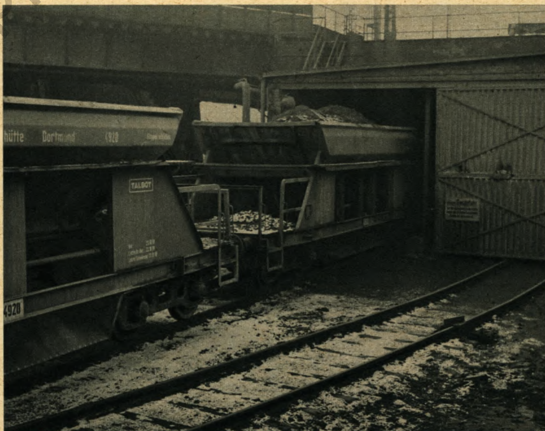
▼ Die Wagen wurden mit Viehsalzlösung bespritzt, dennoch sind die Erze festgefroren. Nun müssen die Waggons in die Auftauhalle geschoben werden
