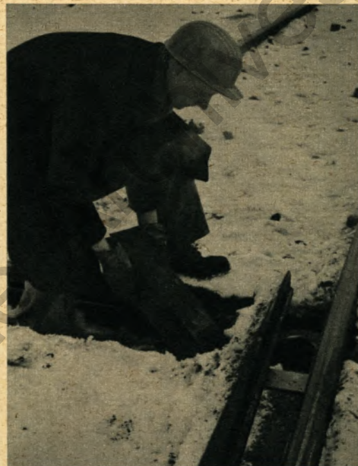
▼ Hier schiebt Manfred Skappeck eine Heizmulde mit brennenden Briketts an die Weichen. An strengen Wintertagen arbeiten 200 bis 250 Männer in drei Schichten gegen Schnee und Frost
