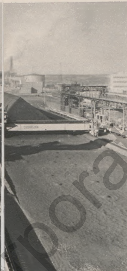
◀ Einer der Knotenpunkte des zwölf Kilometer langen Bandsystems, das den Transport von Kohle und Erz besorgt
