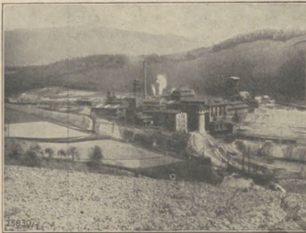
Wenceslaus-Grube mit Kurt-Schacht
