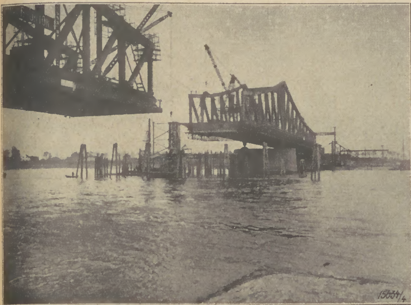
Die neue Düsseldorfer Rheinbrücke bald fertiggestellt
