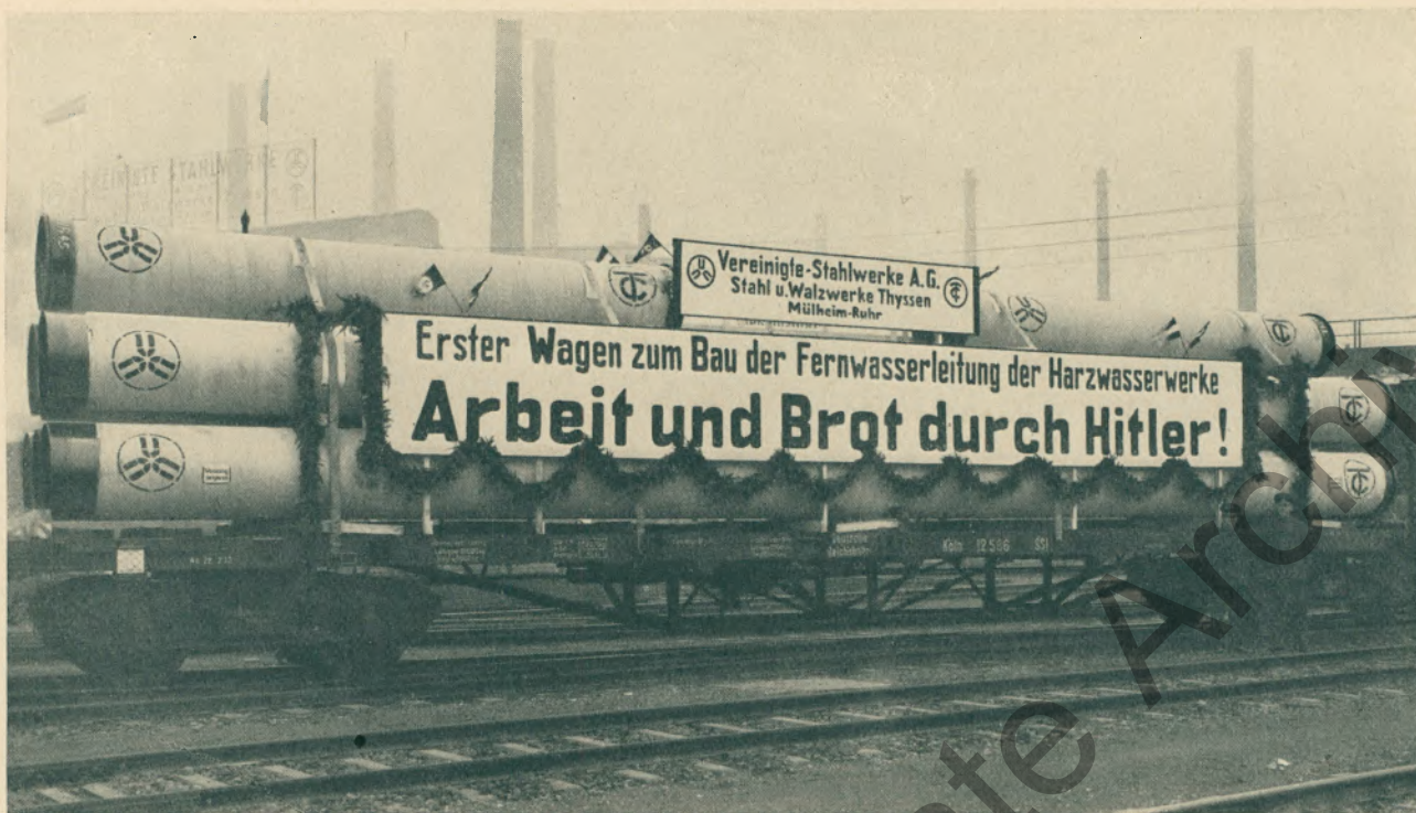
Die Harzwasserwerke haben mit dem Bau der etwa 200 km langen Fernwasserleitung von der Sösetalsperre bei Osterode i. H. nach Bremen ein großzügiges Arbeitsbeschaffungswerk in Angriff genommen, an dem durch Lieferung der Stahlmuffenrohre neben anderen Unternehmungen der westdeutschen Industrie auch die Vereinigte Stahlwerke A. G., Düsseldorf beteiligt ist. Unser Bild zeigt den ersten Güterwagen mit Stahlmuffenrohren von 800 mm Durchmesser beim Verlassen des Mülheimer Werkes der Vereinigten Stahlwerke.
