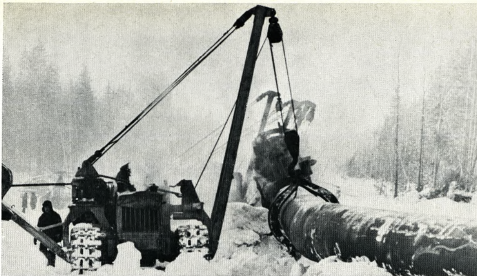
Das Verlegen der Röhren im Lager Meweschi, einem der sechs Erdgasvorkommen im Gebiet von Nadym, geschieht mit modernsten Maschinen. Trotzdem ist die Arbeit besonders im Winter für die Schweißer hart und anstrengend.
