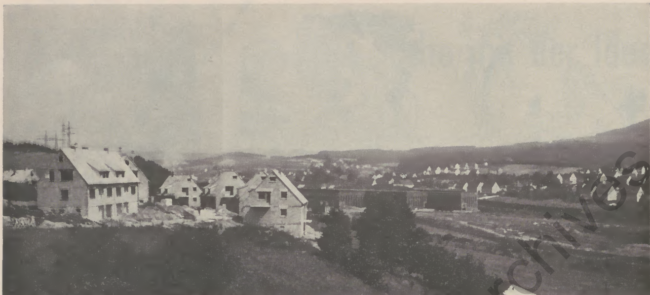
Blick auf den zweiten Bauabschnitt der Siedlung Fellinghausen
