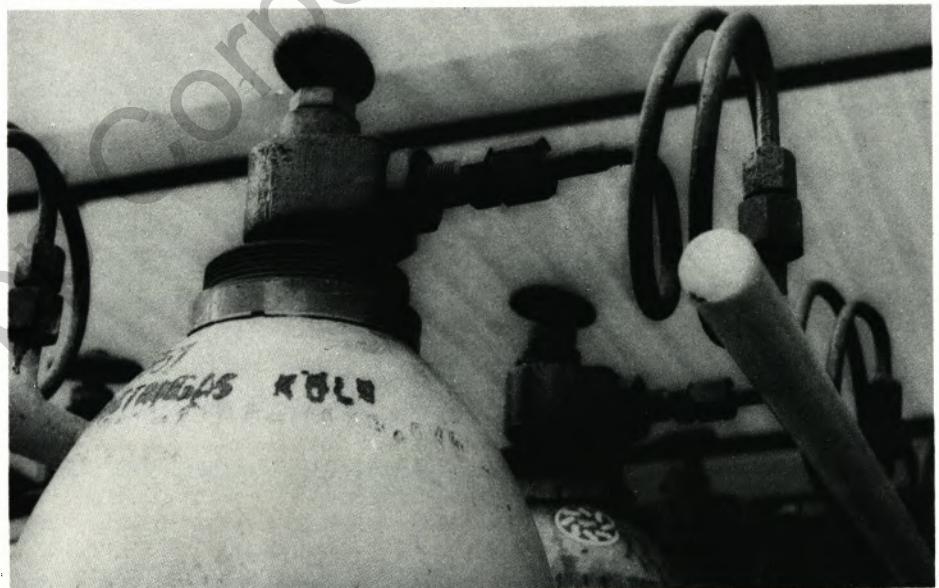
Teilansicht der neuen Bündelstation für die Azetylenversorgung der EWH. Jeweils vier Flaschenbündel sind an die Ringleitung angeschlossen.
