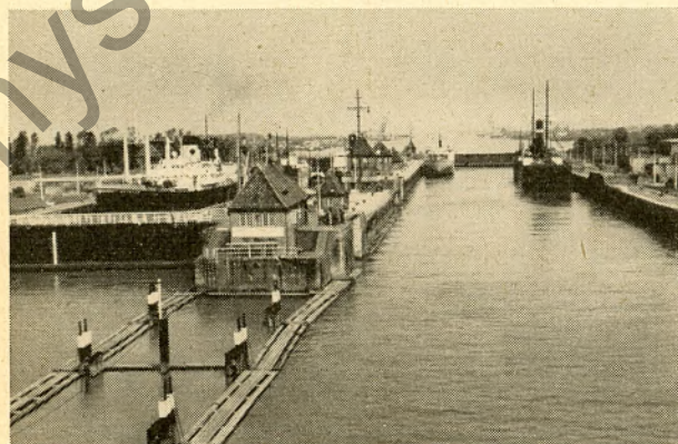
Brunsbüttelkoog - Teilansicht der Schleusen
