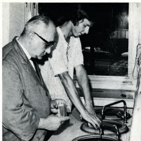
Fritz Holtsteger und Hans-Michael Gündisch an der Naßschleifmaschine bei der metallografischen Schliffvorbereitung.
