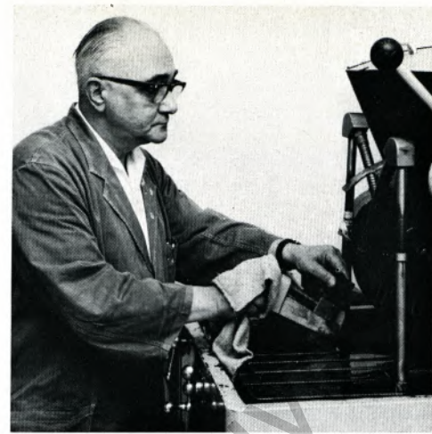
Fritz Holtsteger beim Abtrennen von Proben zur metallografischen Schliffvorbereitung.
