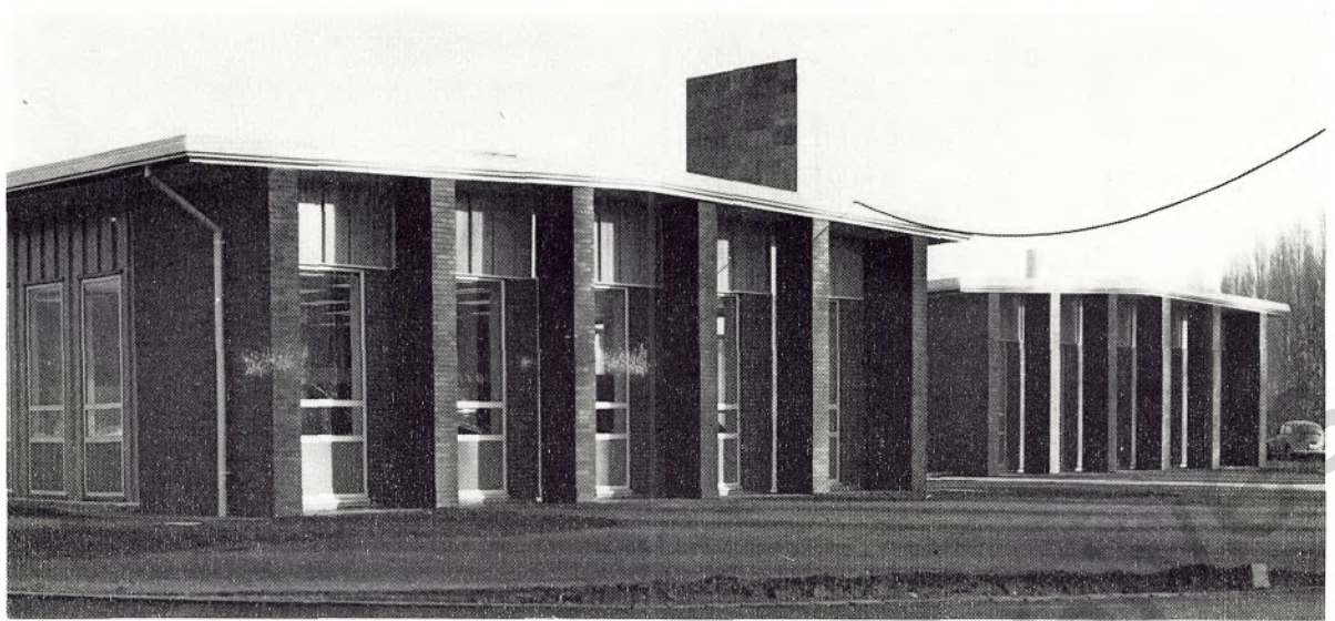
UNSER BILD zeigt die Außenfront des neuen Verwaltungsgebäudes
