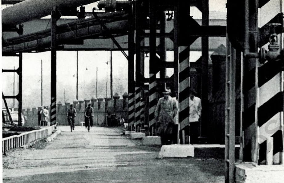
An der Verengung der Werksstraße zwischen Tor 1 und dem Ölbunker des neuen SM-Stahlwerks weist ein schwarz-gelber Anstrich der Posten und Träger auf die Gefährdung der Fußgänger durch den Kraftverkehr hin. Hier ist besondere Vorsicht dringend angeraten
