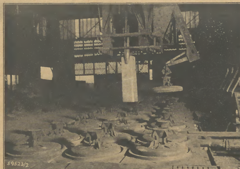
Elektrischer Grubentran mit automatischem Bedelabheber und Blodzange — Tiefofenanlage Walzwerk I
