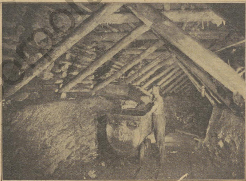
Füllstelle unter einer Schüttelrutsche.
