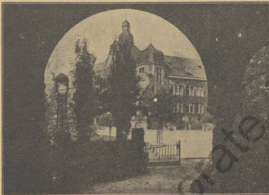
Das Verwaltungsgebäude der staatlichen Grubenverwaltung Westfalen
