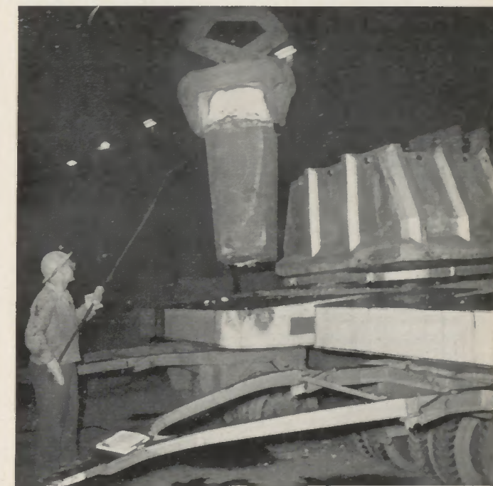
unten links: Die fertigen Blöcke werden aus ihren Formen, den Kokillen, gezogen. Gießer Otto Eggert zieht die Blockhäuben ab und
