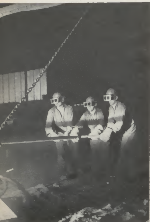
Hier wird verbrauchte Schlacke abgezogen, eine Arbeit, die — wie auch das Einsetzen neuen Materials zur Schlackenbildung, die das obere Bild zeigt — durch die enorme Hitze sehr erschwert wird. Wir sehen unsere Mitarbeiter: Klaus Scheffler, Joseph Groterhorst und Gerhard Temp.
