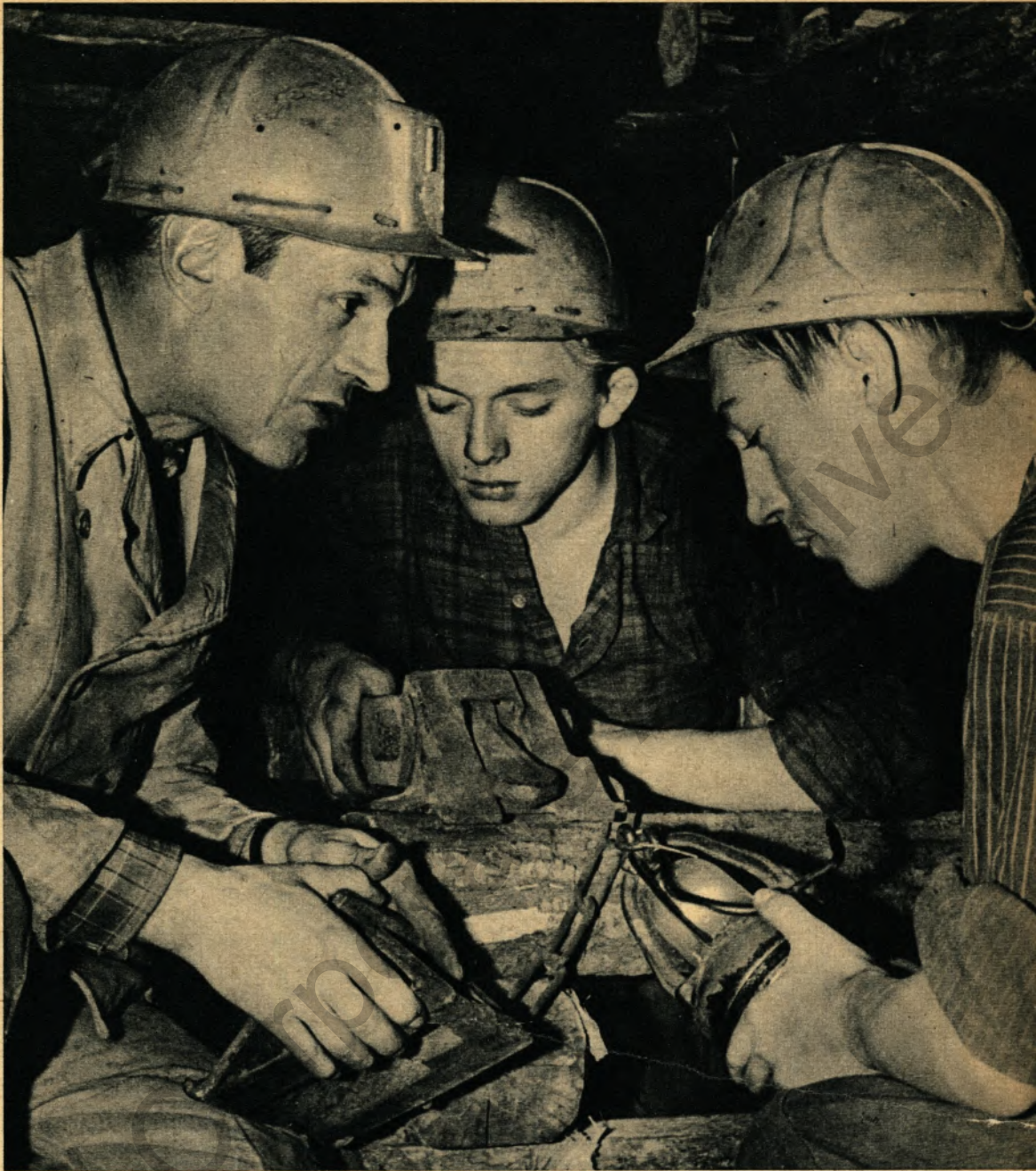
6 Hier „verpackt“ Walter-Karl Siepmann mit Steinen die Hohlräume vor Ort in einem Streckenverzug
