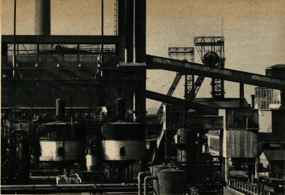
Das neue Kraftwerk auf der Schachtanlage Fürst Leopold-Baldur in Hervest-Dorsten, das den Probebetrieb schon aufgenommen hat. In diesem Kraftwerk wird außer den bei der Kohleaufbereitung anfallenden Mittelprodukten und sonstigen minderwertigen Kohlsorten in großem Maß auch die schwer absetzbare Flamm-Feinkohle verwendet
