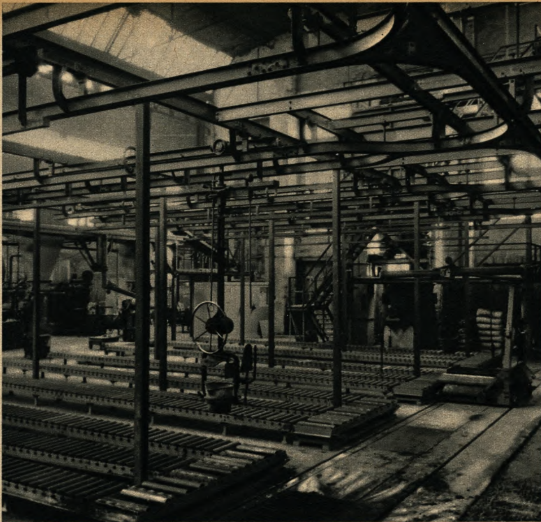
Blick auf die Gießanlagen des Werks Werdohl der Schmiedag. Hier werden nach einem Spezialverfahren im „Sphäroguß“ verschiedenartige Autoteile hergestellt. Im Vordergrund Fließbänder für die Formkästen
