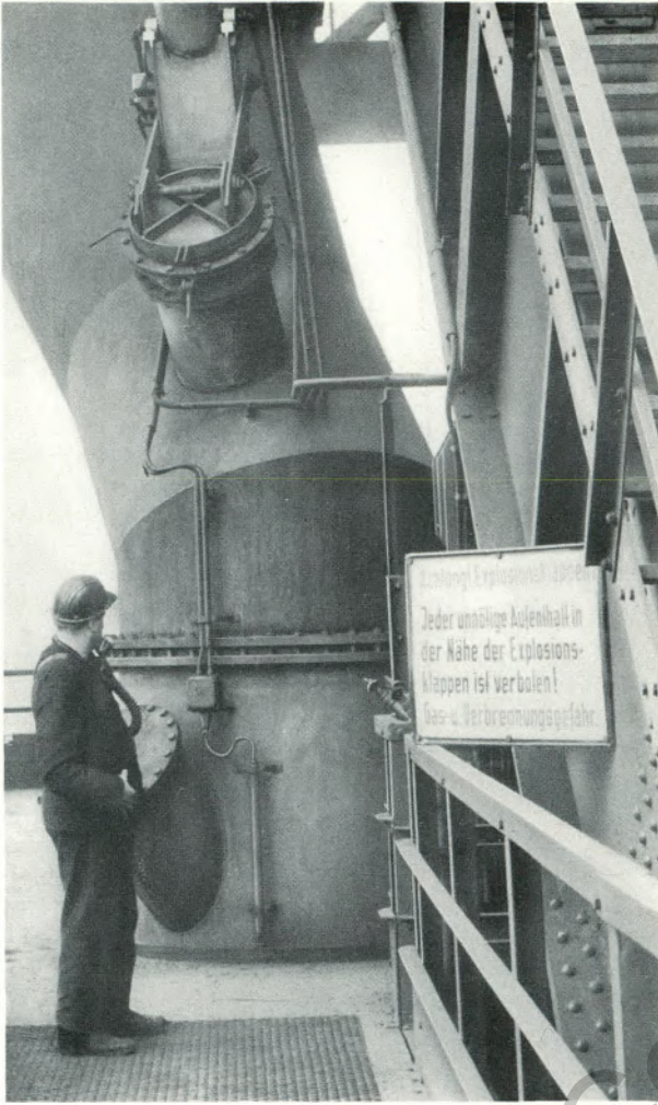
Automatische Belüftungs- und Explosionsklappen an der Gicht.
