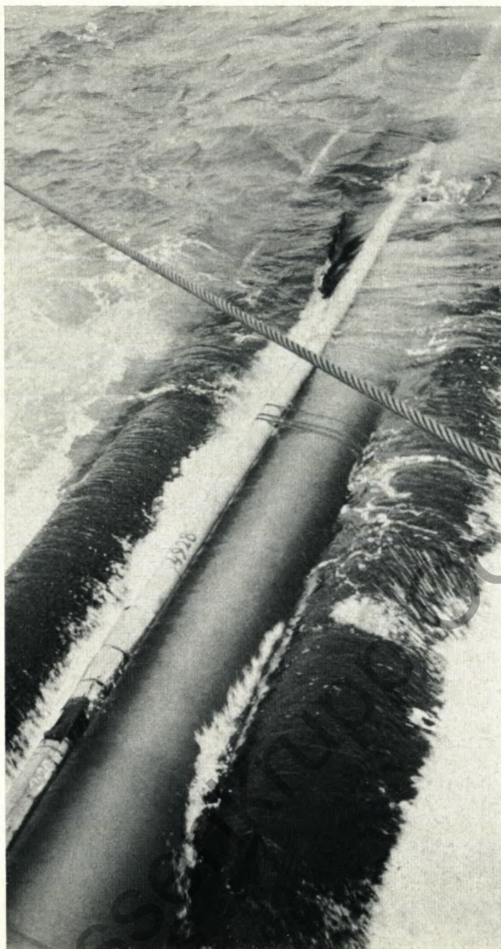
Unser Foto hält den Augenblick fest, in dem die Leitung zwischen 2 Schwimmkörpern in einem sehr flachen Bogen in die Nordsee eintaucht.
