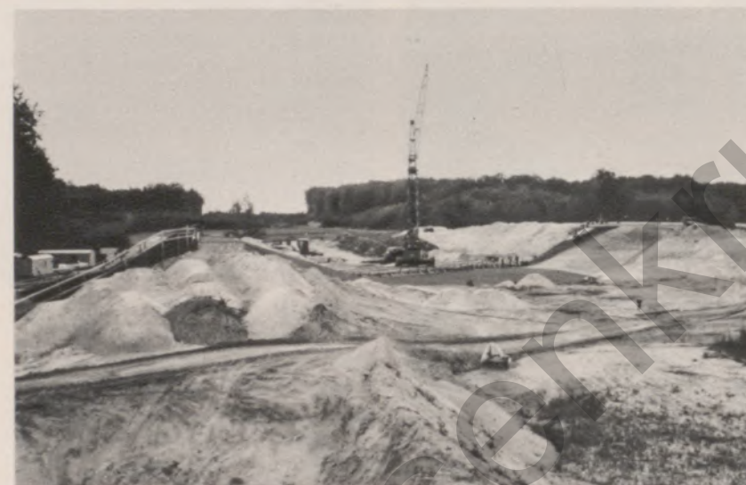
▲ Noch ist kein Wasser im Elbe-Seitenkanal, der hier – bei Erbstorf – über Straße und Schiene hinwegführt
