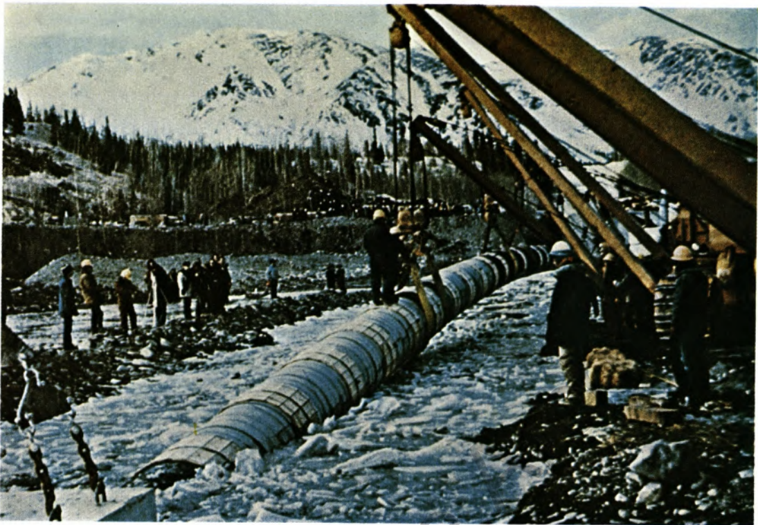
Verlegen der Pipeline in den Erdbereich.
