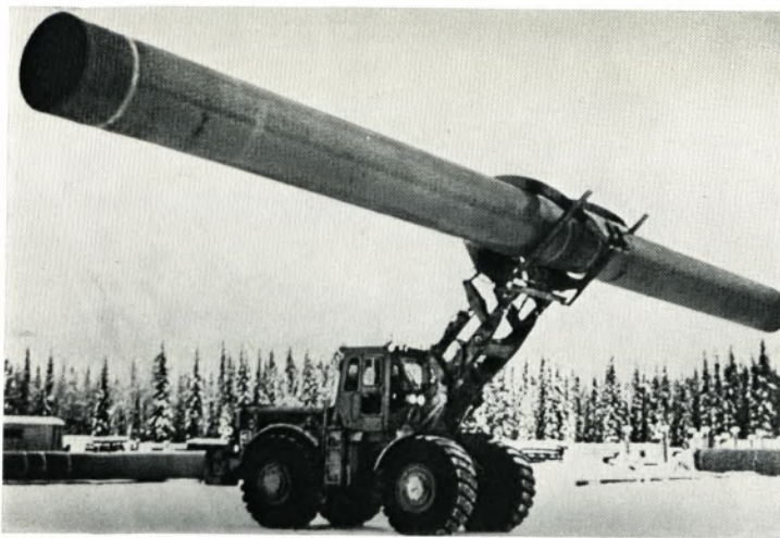
Geschweißte Doppelrohrlänge
