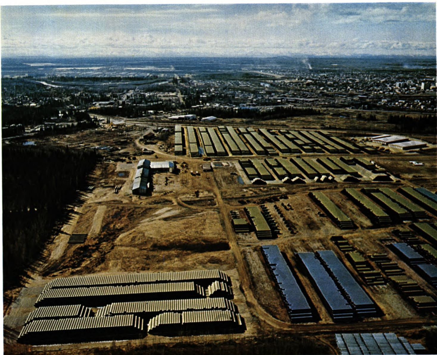
Ansicht des Pipeline-Rohrlagers in Fairbanks.
