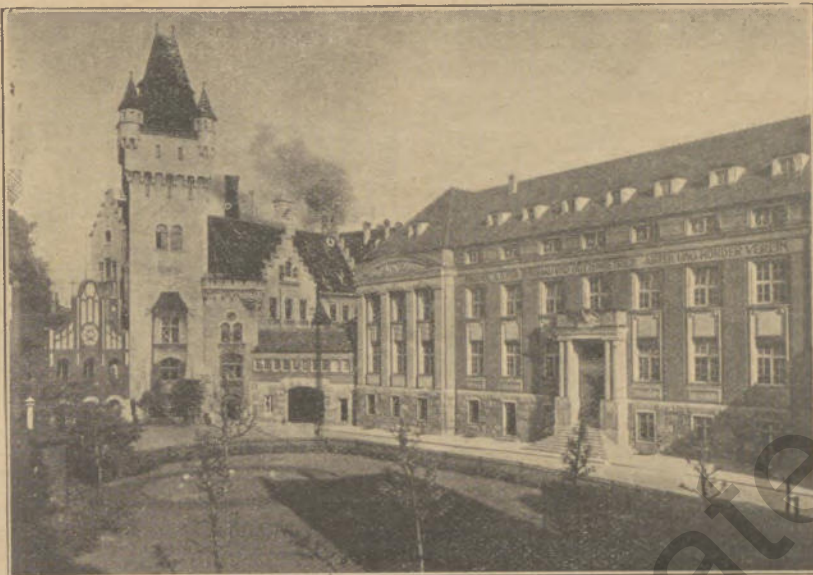
Das Verwaltungsgebäude der Aht. hoerder Verein.
