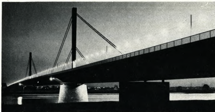
Die von unserer Tochtergesellschaft August Klönne, Dortmund, erbaute Brücke über den Rhein bei Leverkusen zur Nachtzeit.
