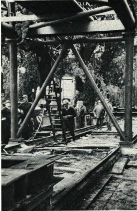
Eine der fertigen Uferstützen, die für das Einschwimmen der Brücke errichtet wurden.
