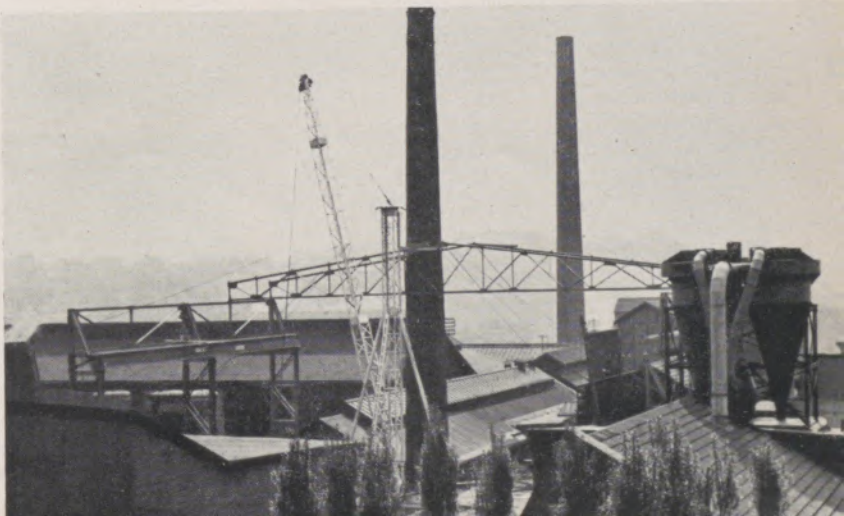
Montage der Kranbahn
