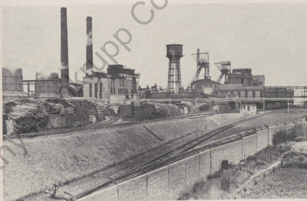
Zechenanlage mit 2 Fördertürmen (rechts) und Kraftzentrale mit Kesselanlage und Kühlturm (links) der Arenberg-Bergbau-Gesellschaft m.b.H., Abteilung Prosper, Bottrop
