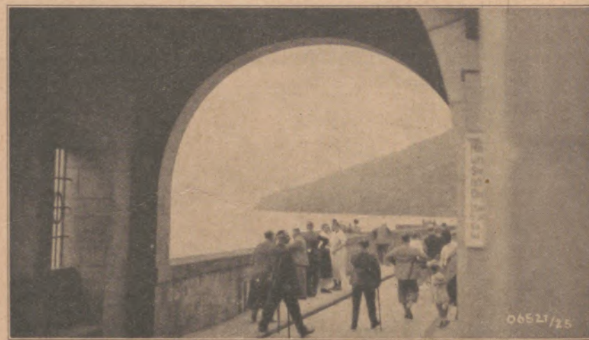
An der Sperrmauer des Edersees
