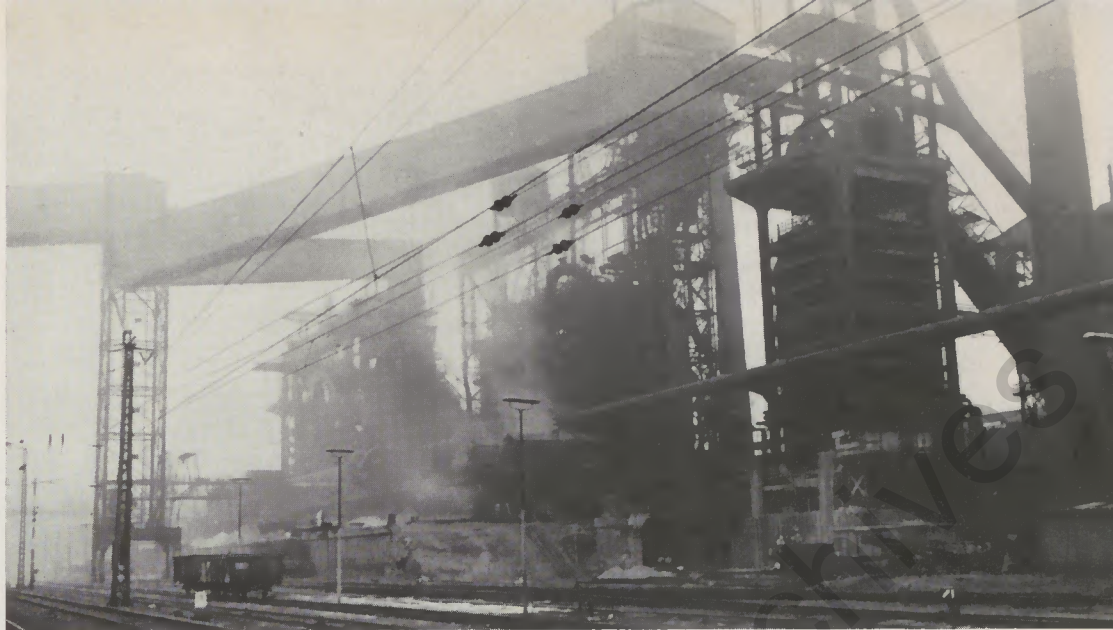
Werk Schalker Verein (Gelsenkirchen): Blick auf die Hochofenanlage
