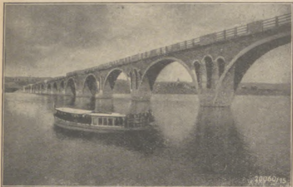
Brücke bei Körbecke am Möhnesee
