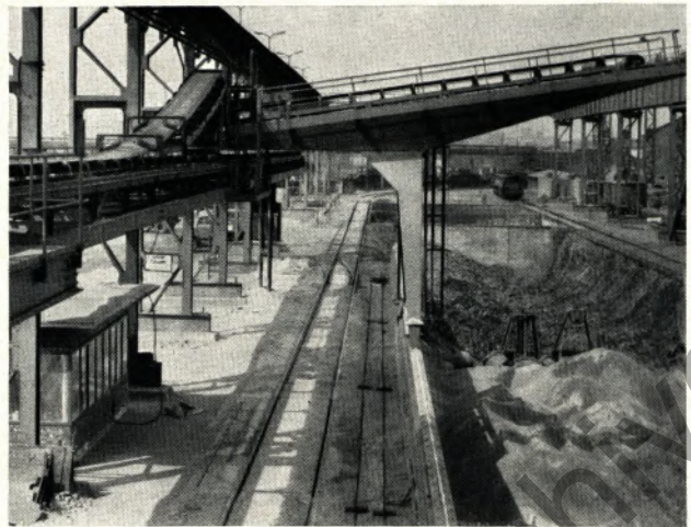
Sandlager und Schlackenkippe unserer neuen Schlackengranulierung
