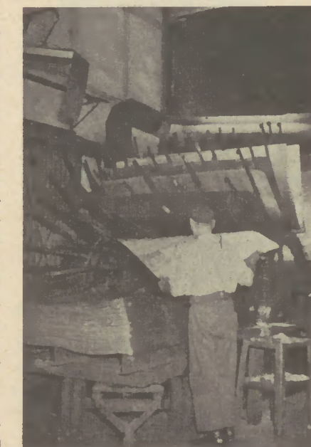
Abnehmen der verzinkten Tafeln vom Kühlrad
