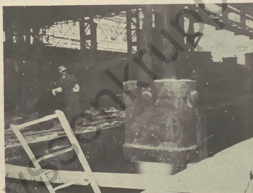
Kokillenmann beim Anhängen einer Kokille mittels Balancier
