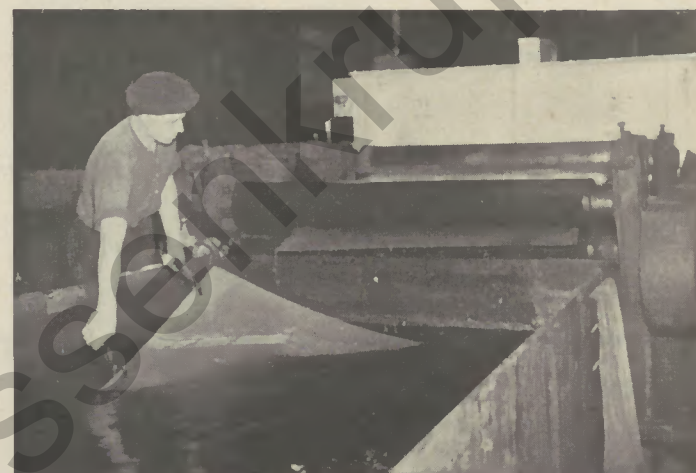
Einführen der gebeizten Tafeln aus dem Wasserkasten ins Flußmittel. Im Hintergrund der Trockenofen.
