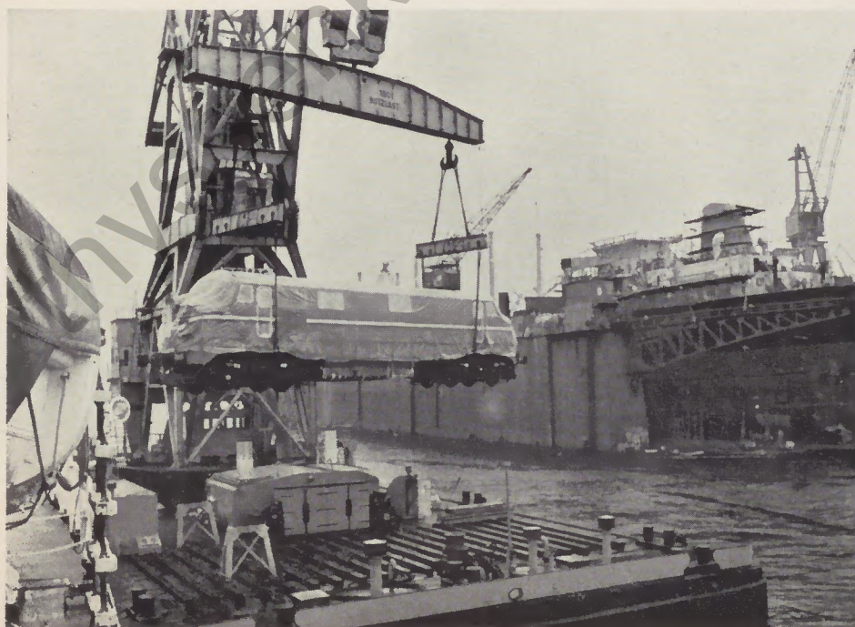
Abb. 6 Verladung der letzten diesel-elektrischen Lokomotive in Hamburg aus einem Auftrag von 70 Stück für die Ägyptische Staatsbahn. Die Lokomotiven haben eine Leistung von 1425 PS
