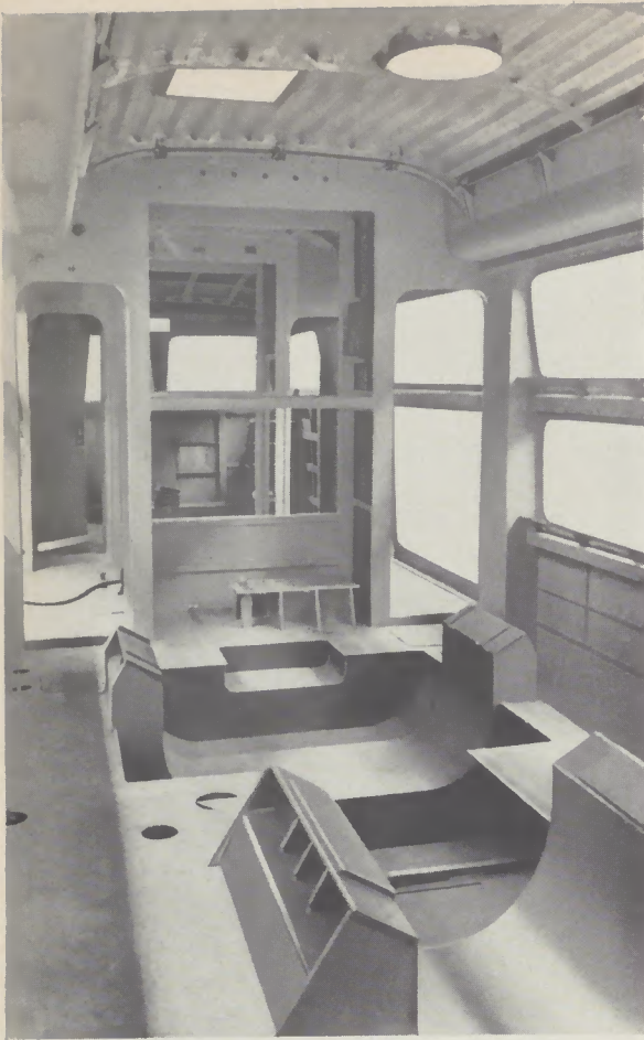
Abb. 4 Maschinenraum, dahinter Heizraum und Führerstand 2
