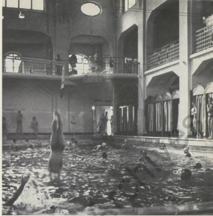
Stadtbad Duisburg Ruhrort, Apostelstraße
