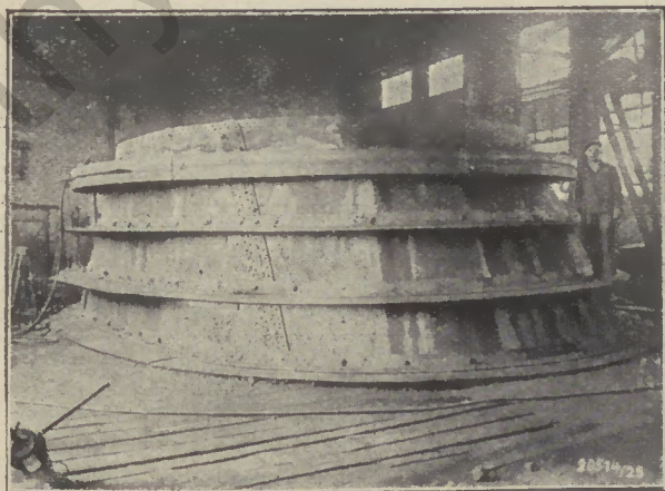
Bild 3: Einlauftrumpete zwischen Speicherbecken und Stollen, ovale Form von 9,6 mal 6,2 m l. W.
