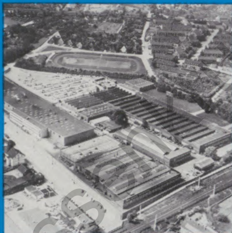
In diesem Jahr produziert die Magnetfabrik 35 Jahre auf dem Gelände in Dortmund-Aplerbeck. Deshalb wird ein kurzer Abriss über die Ge- schichte dieses Werkes gegeben. Seite 2-3.
