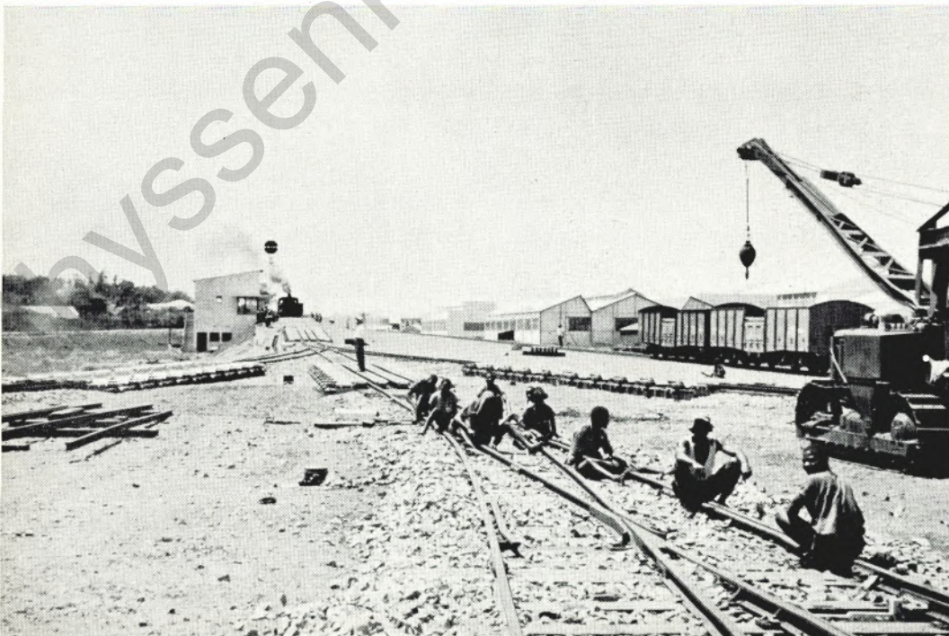
Oberingenieur Pollmann fährt die vier neuen Gleisbremsen ein. Ihre Lage am Ablaufberg des Hafenbahnhofs ist auf dem unteren Bild deutlich zu erkennen. Im Vordergrund eine Kolonne von afrikanischen Arbeitern
