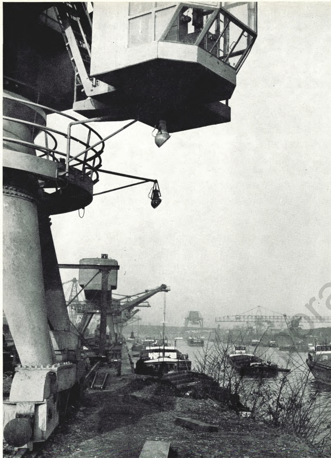
Neue Kräne geben dem Werkschafen Schwelgern eine höhere Umschlagskapazität
