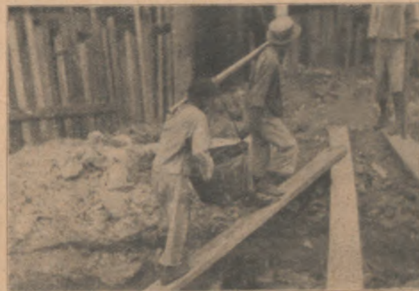
Während bei uns Ausschachtungsarbeiten mit Baggern und modernsten Hilfsmitteln gemacht werden, wird in China noch mit Spaten und Pidel gearbeitet und die ausgeschachtete Erde mit Körben herausgetragen
