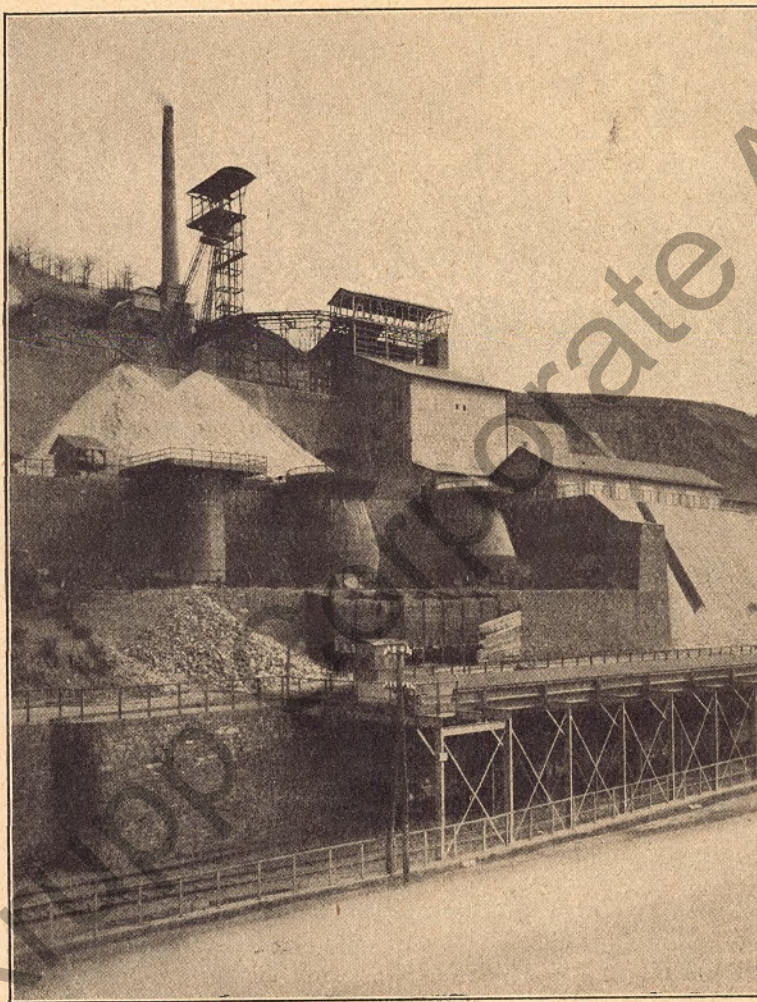
Erzgrube im Siegerland. Schachtgerüst mit Aufbereitung, Röstöfen und Verladung
