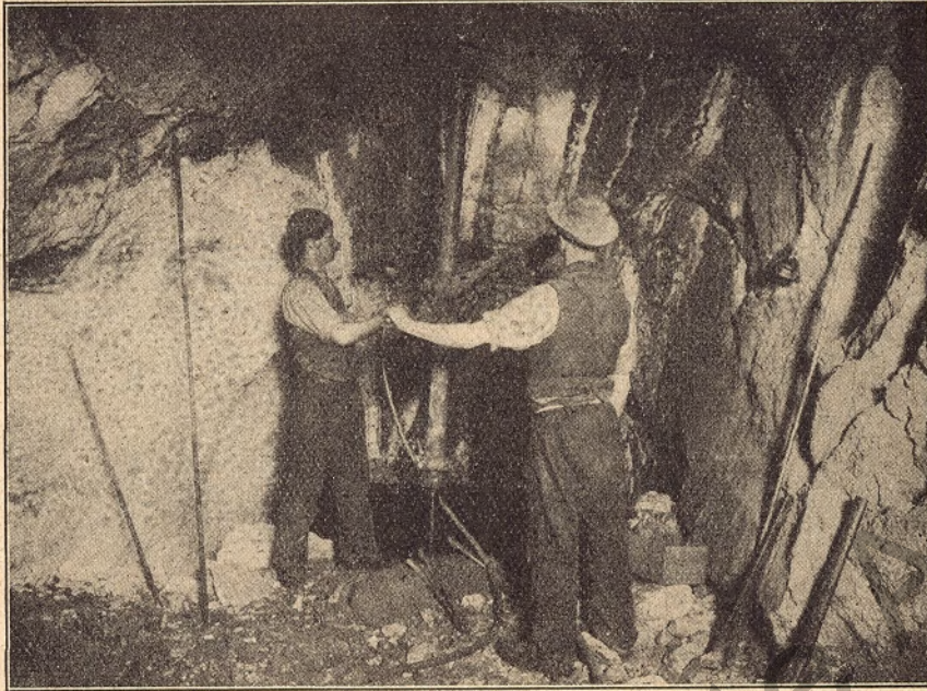
Phot. von Baumgärtel
