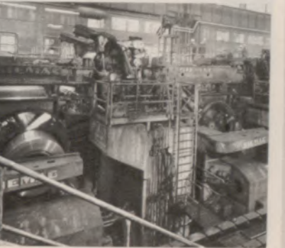
▲ Um Bunde bis zu einem Durchmesser von 2,2 Meter aufwickeln zu können, wurden zusätzlich zwei Unterflurhaspel eingebaut
