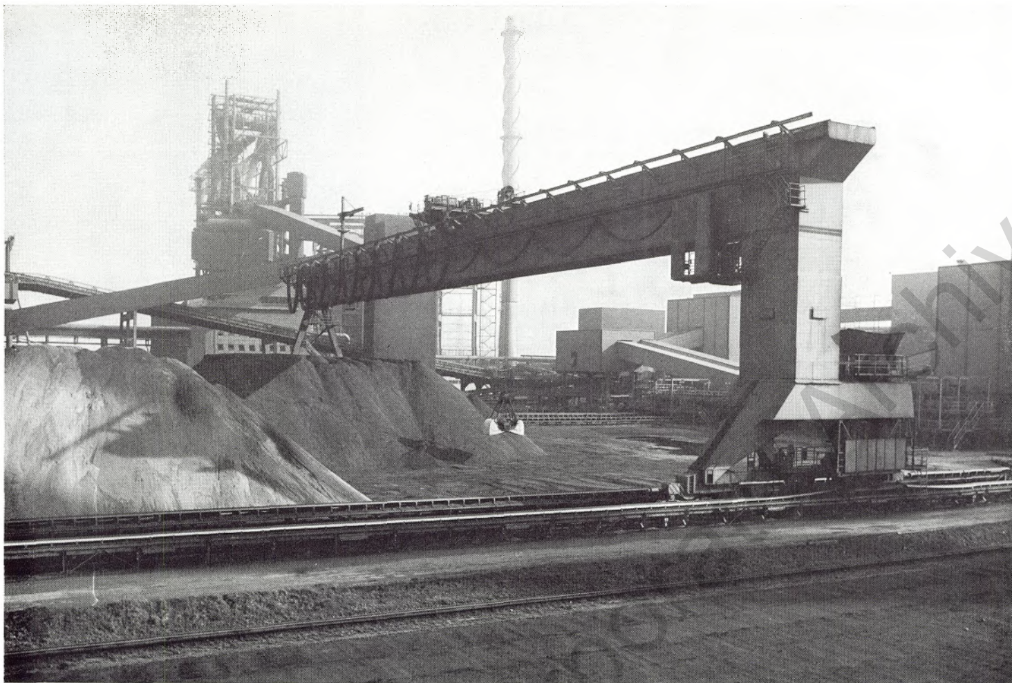
Gesamtansicht der Erzladebrücke H 52 der Möllervorbereitung für die Sinteranlage Schwelgern mit Blick auf den Hochofen, der im Hintergrund zu erkennen ist.
